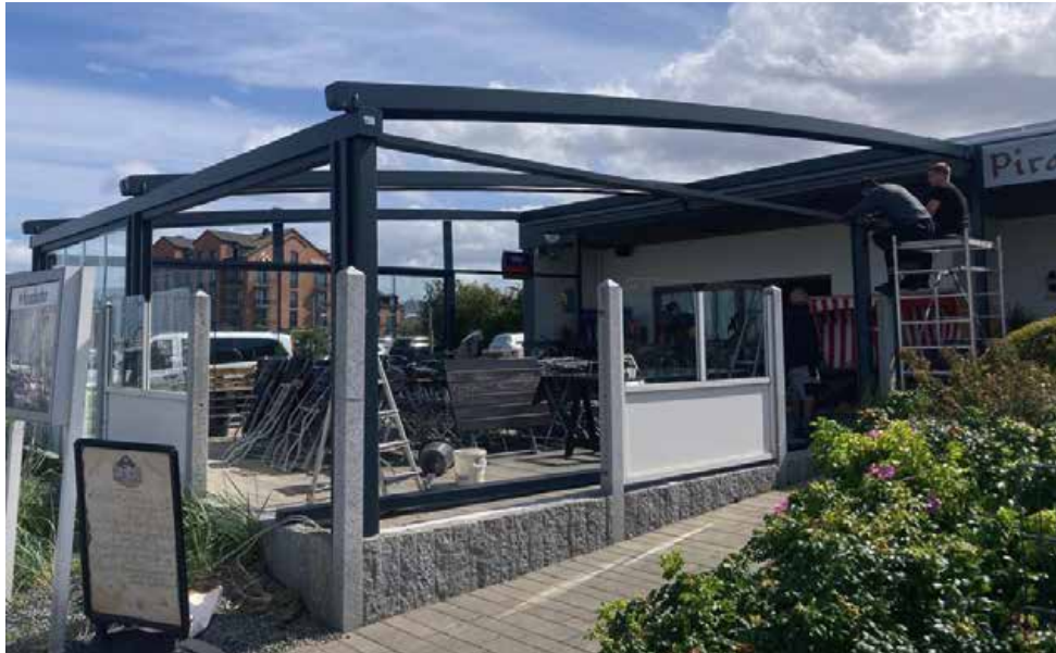
Der alte Windschutz weicht dem neuen Wintergarten
