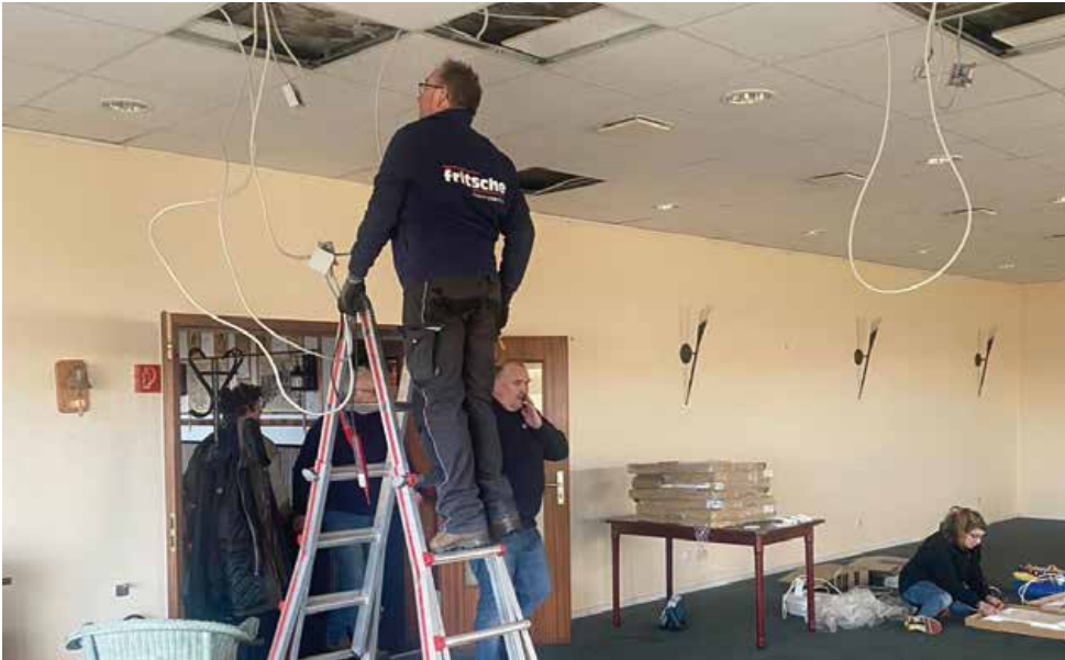
Eine neue Deckenbeleuchtung entsteht
