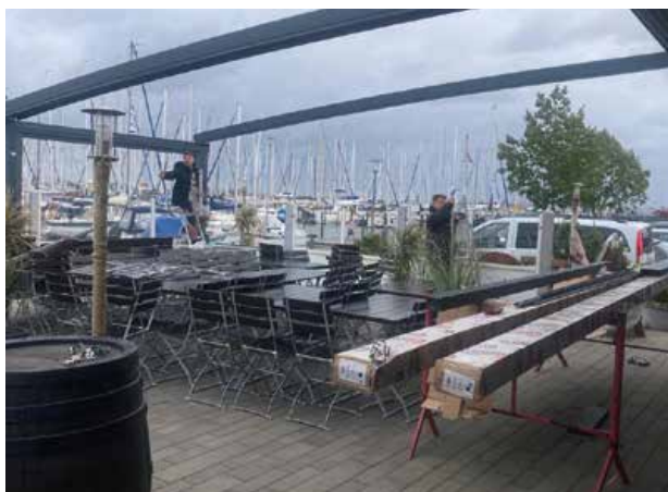
Eifrig wird montiert
