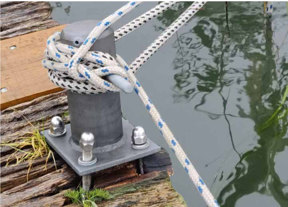
Dank abgespannter Stegklampe lag die La Guapa am Morgen ruhig und sicher auf dem temporären Liegeplatz.
